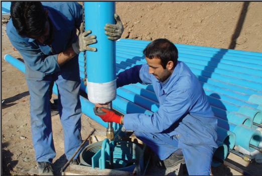
برای اولین بار در شرکت آبفای استان قزوین لوله های UPVC (کالمن) در چاه های آب شرب نصب و راه اندازی شد.
